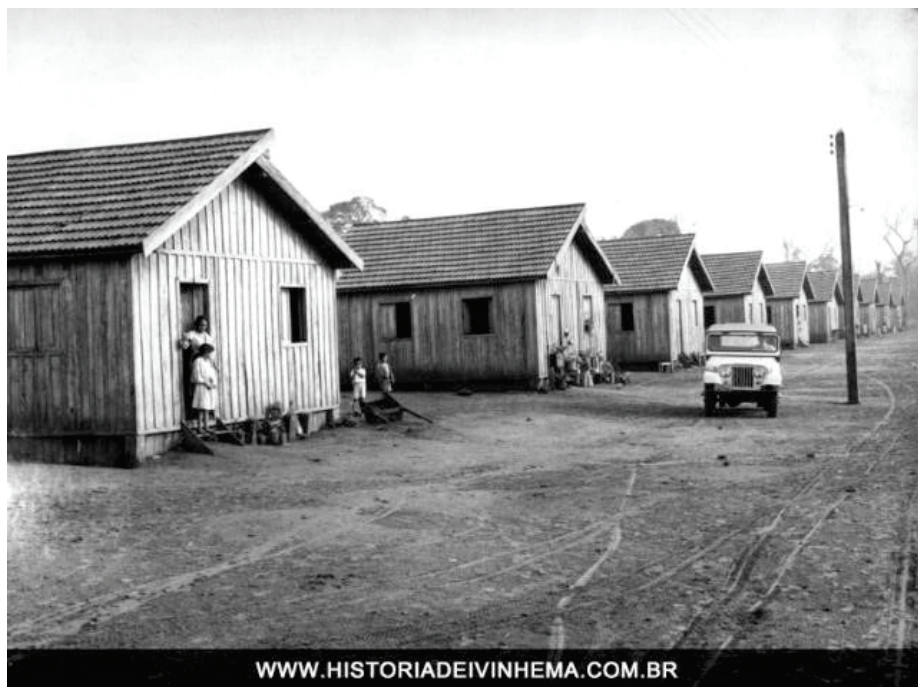
Foto 3: A coletiva. Casas construídas pela SOMECO S/A
