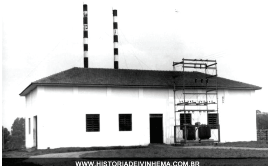
Foto 4: Usina termoeétrica construída em 1973
